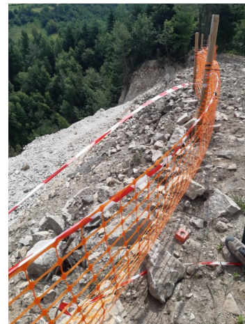
Mise en place d'un filet au sommet de l'effondrement (la borne est en limite de site)
