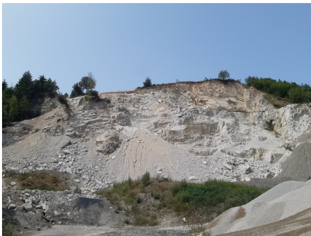
Effondrement des fronts de taille
